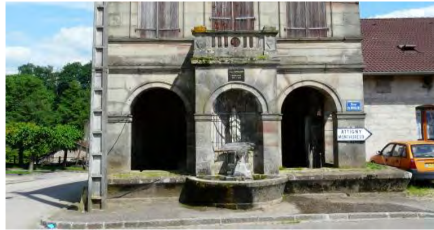
Photo 24: Fontaine-lavoir – Belmont lès Darney (Source : petit patrimoine)
