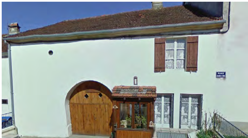
Photo 22: Façade de maison traditionnelle récemment restaurée – Passavant la Rochère (Source : Google Earth 2011)
